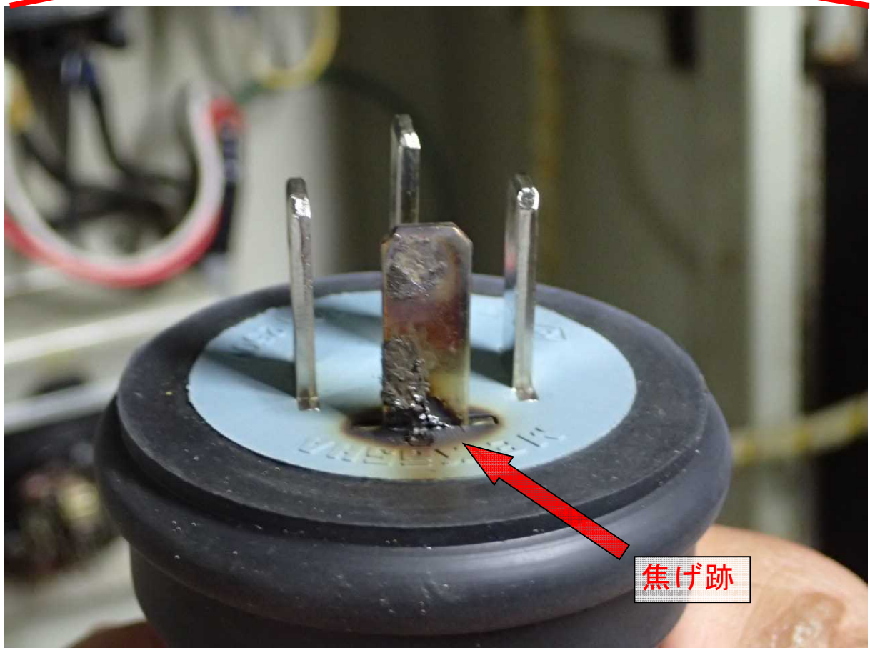
火災状況写真
